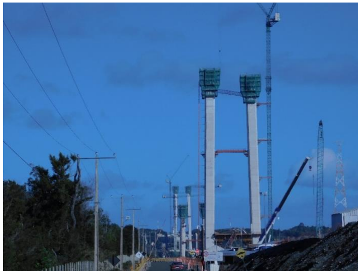
Figura 3. Pilotes norte, Puente Chacao. Fotografía: propia autoría. 28 de julio 2024.
