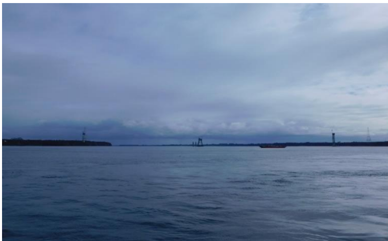
Figura 2. Pilotes Puente Chacao, Canal de Chacao. Fotografía propia autoría. 11 de octubre 2024.
