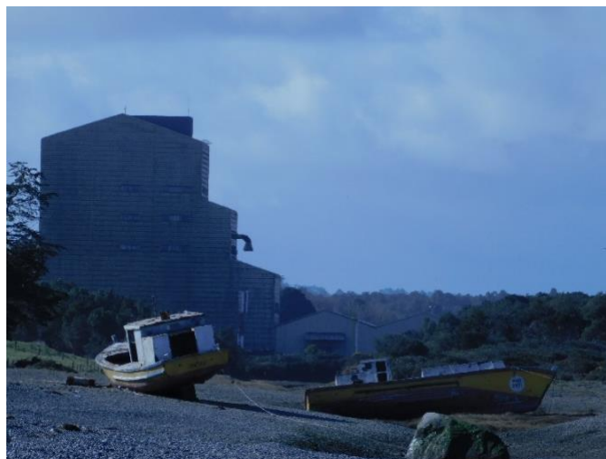
Figura 6. Empresa Skreting en las costas de Pargua. Fotografía: propia autoría. 22 de octubre 2024.
